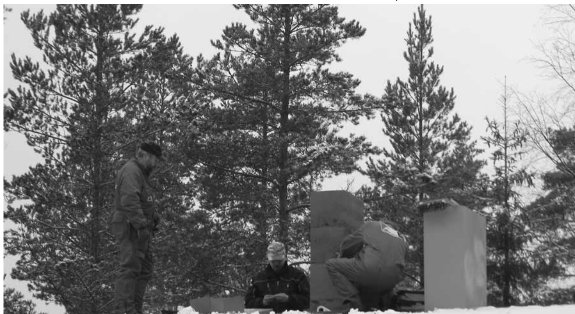
Piippu oli niin valmis paketti, että harkkojen päälle sujautettiin valmis peltihuppu. Unto valvoo piippumuurari Vesan työtä ja Hannu pitelee piippua paikallaan.
