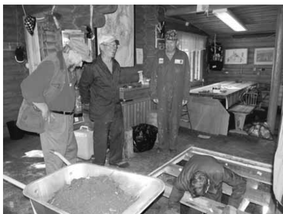
Unto, Osmo ja Hannu naureskelevat pomoina, kun Jouko kaivaa loputonta turvekerrosta.
