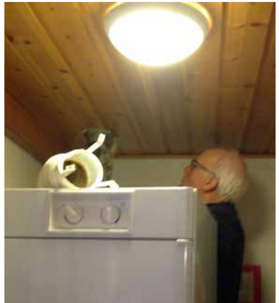
Saarihelyn kuivauskaapin ilmastoinnin korjausta
