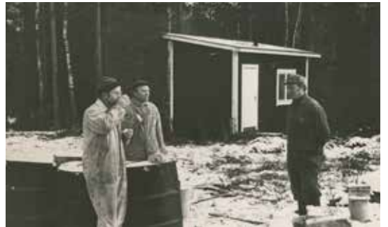
Ensimmäiseksi rakennettiin ulkovarasto.
