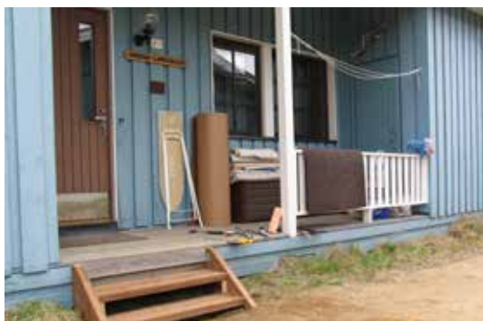
Saarihely; joku remontti näyttäisi olevan käynnissä
