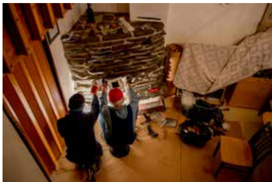
Uuden luukun asennus Saarihelyn takkaan
