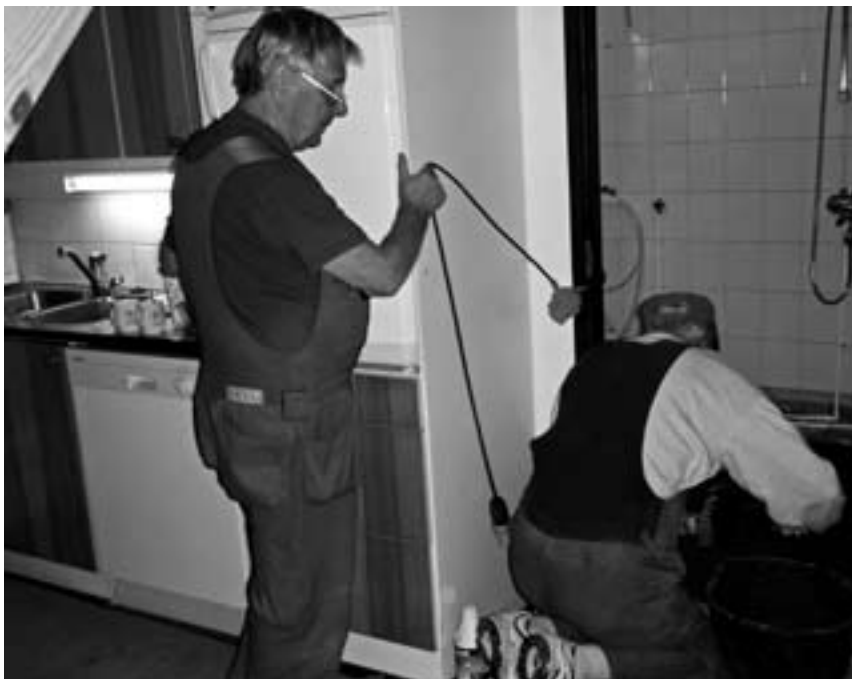
Lattialämmityskaapelien peittovalu meneillään. Kari ja Heikki työn kimpussa.
