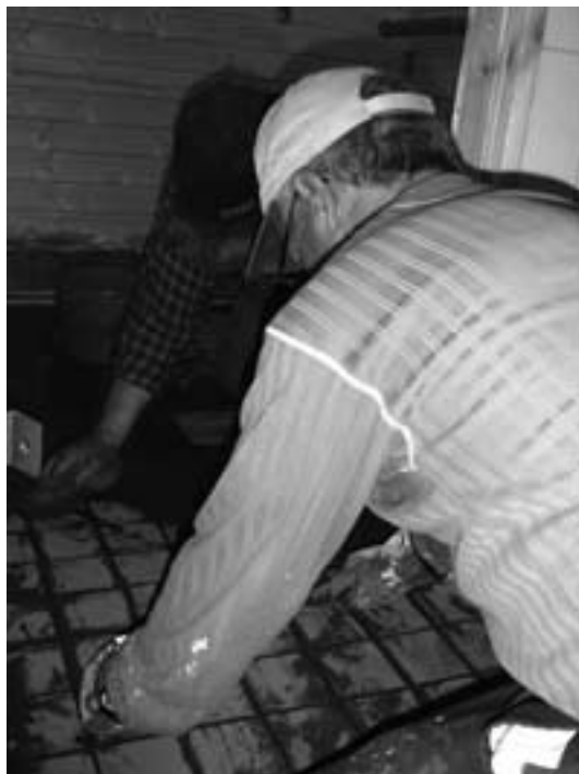
Lattialaattojen saumausta Suorittivat Unto ja Osmo.
