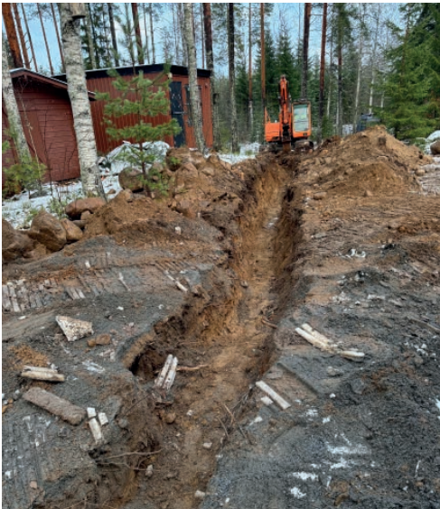
Kaivanto vesijohtoa ja saattolämmitystä varten.
